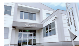
熊本テクニカルセンター (熊本県合志市) 床面積: 382㎡ (2階建)
