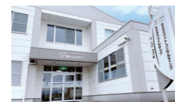
熊本テクニカルセンター (熊本県合志市)
