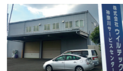
神奈川サービスセンター (神奈川県大和市)
