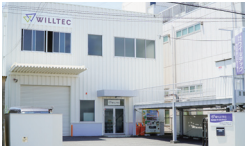
守口工場 （大阪府守口市） 工場面積：907.2㎡ 設備：汎用旋盤 / 溶接機 / フォークリフト / 汎用フライス / CAD 各種 / クレーン×3/ エアー / チラー / 各種工具一式
